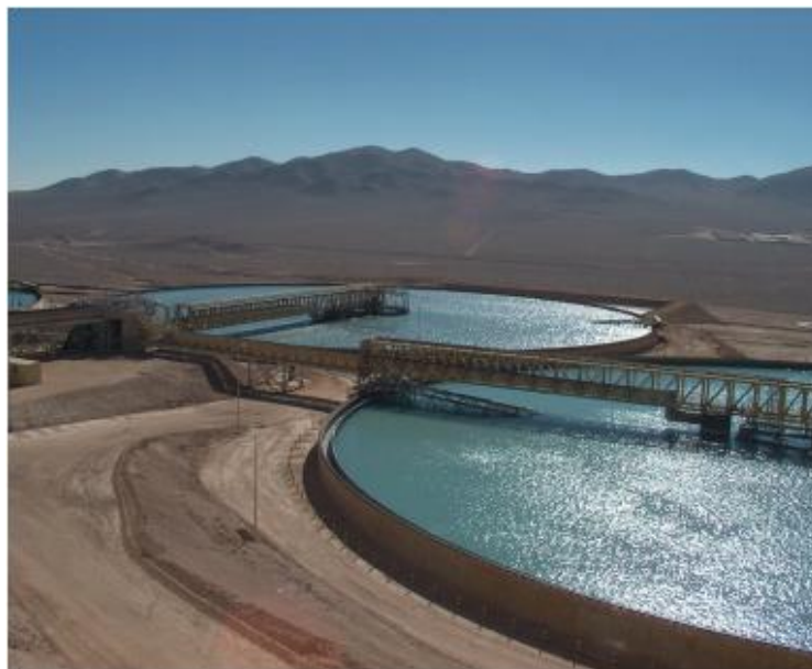
Figura 2.3. Sedimentador de alta capacidad. (FLSmidth, 2024)
