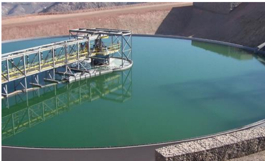
Figura 2.5. Clarificador. (FLSmidth, 2024)
