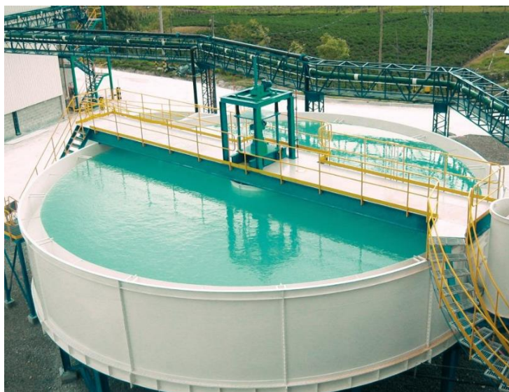
Figura 2.4. Sedimentador convencional con puente. (FLSmidth, 2024).
